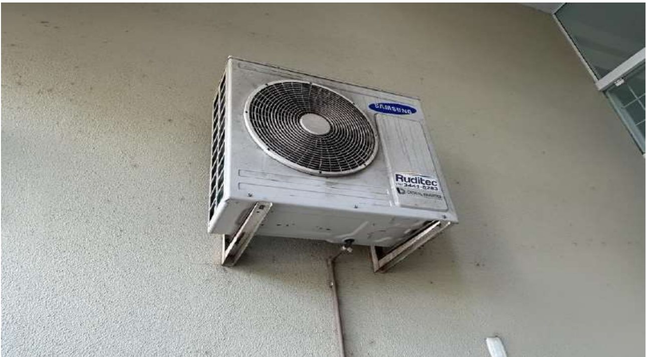
Foto 03: Unidade condensadora 1.
